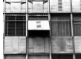
14 Edificio a Square Mozart, dettaglio della facciata, Parigi, 1953 - 54. Centre Pompidou, Parigi, Bibliothèque Kandinsky, Fonds Jean Prouvé. © VG Bildkunst, Bonn
